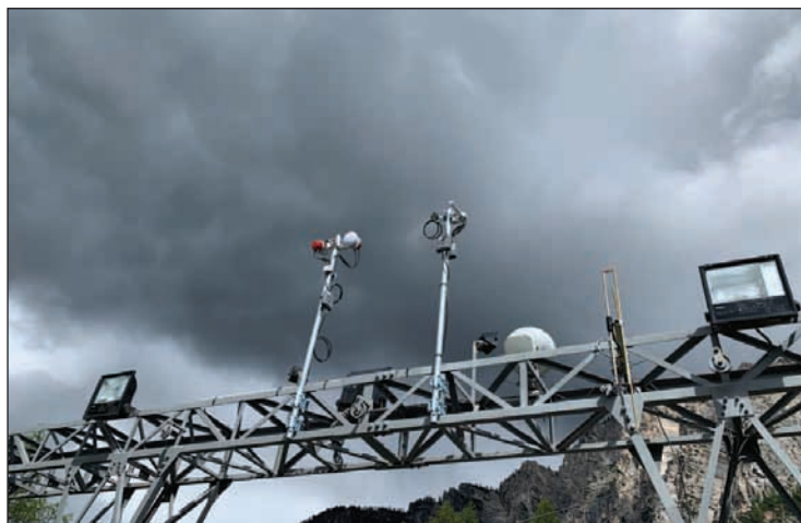
Apparati RF posizionati sulla copertura della stazione intermedia che permettono di irradiare il trackside per la comunicazione terra/bordo e connettere le stazioni
